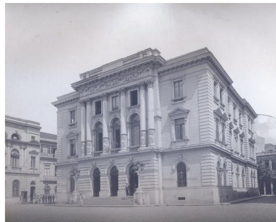
Primeira sede da Secretaria, em 1896. Atualmente, o edifício é sede da Secretaria da Justiça (Foto: Centro de Memória Unicamp)
